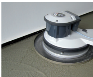
Заглаживание бесшовного пола
