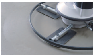
Заглаживание с помощью лопастей
