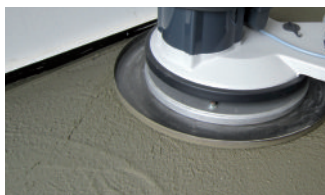
Затирка с помощью диска
